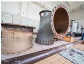
AXIAL HYDRODYNAMIC FLOW PUMP IN WASTEWATER PLANT.
